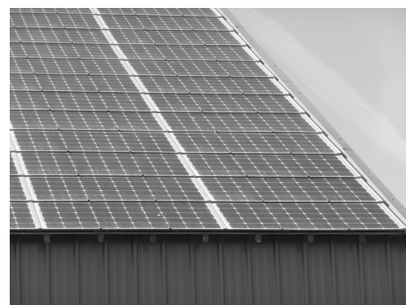
Détail du toit
